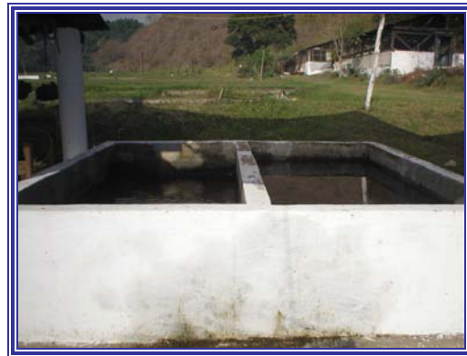
Figura No.6 Piletas de Despacho
