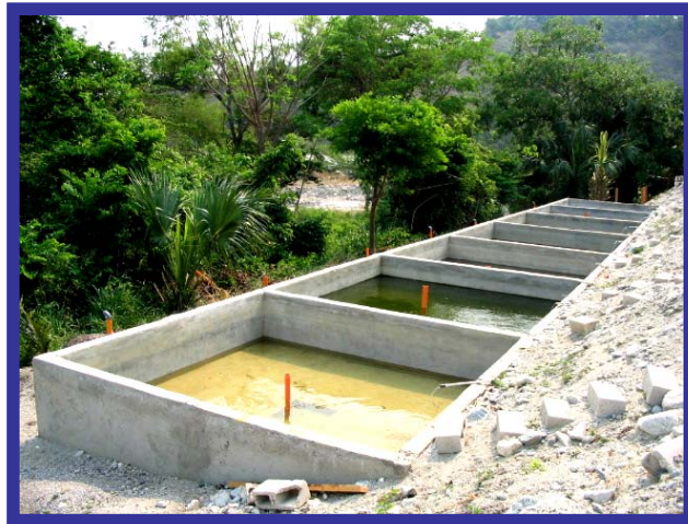
Figura No. 2 Estanques de mampostería para la reversión de alevín de tilapia.
