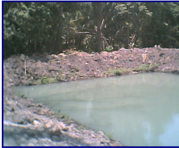
Figura No. 58. Diseño defectuoso de infraestructura
