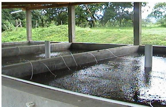
**Figura No. 15** Sistema de aireación en piletas de reversión sexual, Finca Pecuaria, ITECNOR.
