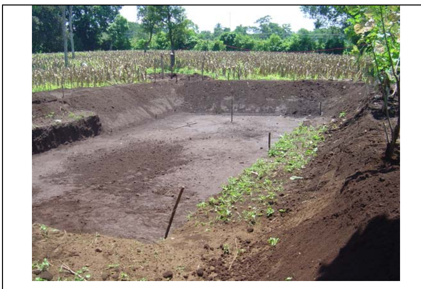
Figura No. 22 Construcción estanque No. 2
