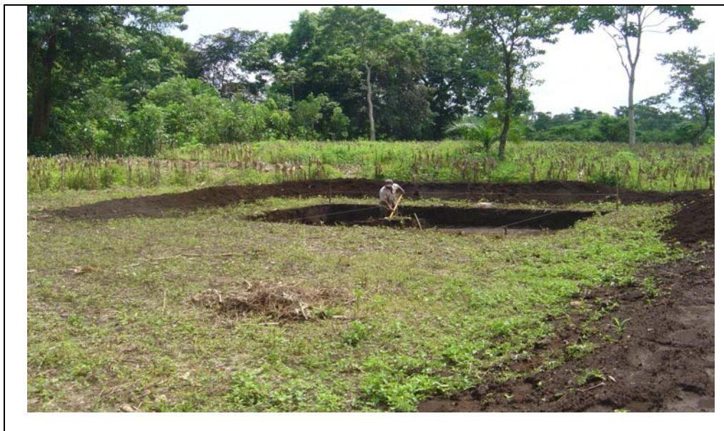
Figura No. 21 Construcción del estanque No. 1
