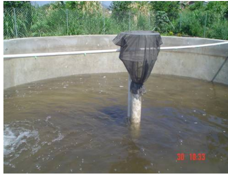
Figura No. 12 Desfogue de los tanques
