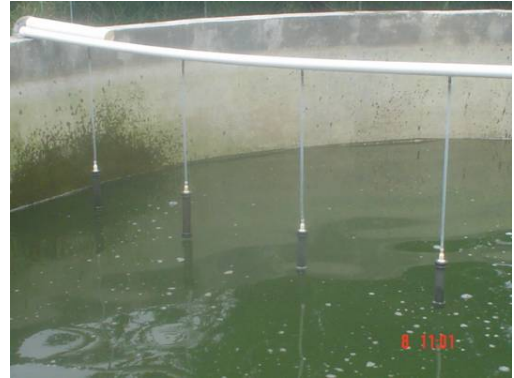
Figura No. 84 Aireación por tanque
