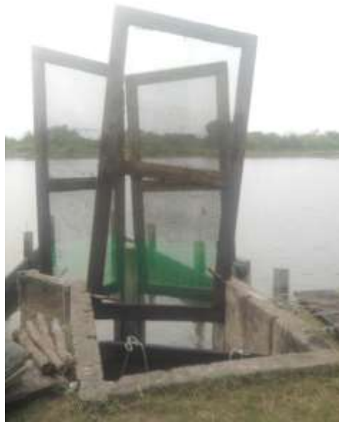
Figura15. Cajas y filtros de la piscina 16.
