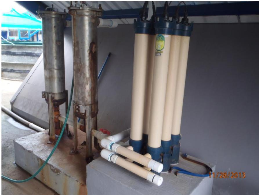
**Figura No. 6.** Sistema de filtrado UV de seis lámparas
