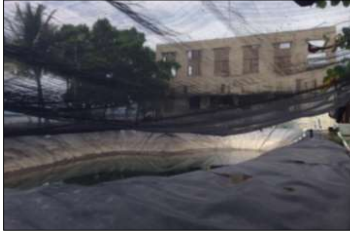
Figura 5 Reservorio de agua de la Estación de Biología Marina
