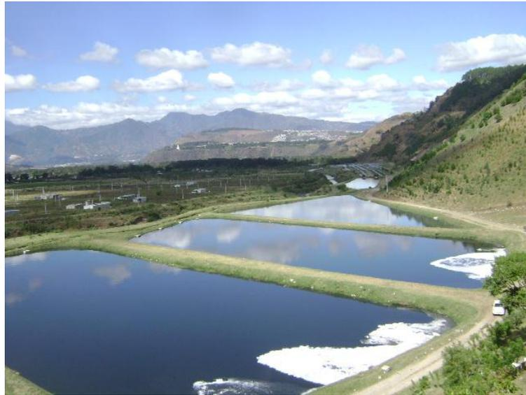
**Figura No. 1** Tratamiento secundario en Planta de Tratamiento de Aguas Residuales, La Cerra
