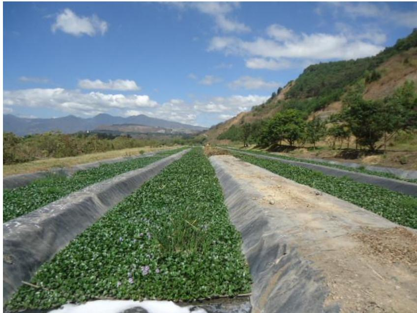
**Figura No. 4** Biofiltros de la planta de tratamiento La Cerra (Trabajo de campo (2014).
