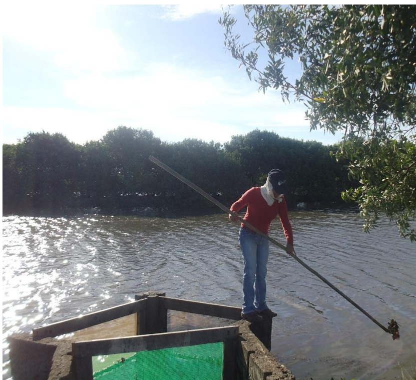
Figura No.13 Limpieza de filtros
