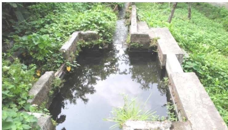
Figura No. 5. Caja de sedimentación en el Caudal No.2 (Trabajo de campo, 2013)
