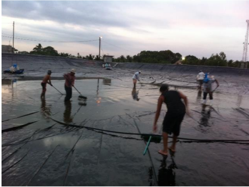
Figura No. 3. Limpieza y desinfección de estanques (Trabajo de campo, 2015)
