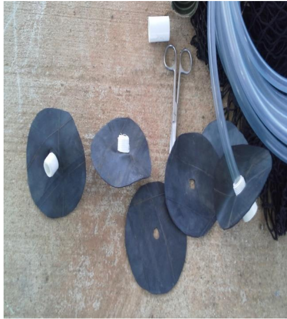
Figura No. 7. Instalación de accesorios en la manga para la conducción de biogás (Trabajo de campo, 2015)
