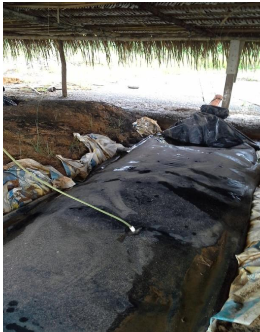
Figura No. 8. Salida de biogas en manguera de ½” ubicada en el centro del biodigestor (Trabajo de campo, 2015)
