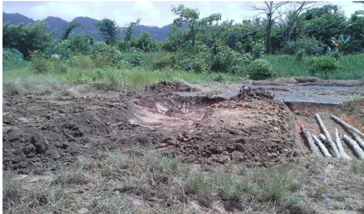
Figura No. 5. Acabado en zanja de biodigestor (Trabajo de campo, 2015)
