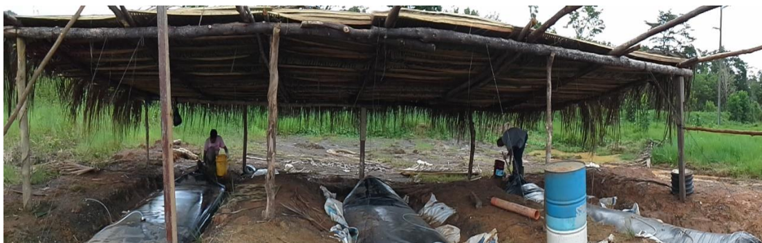
Figura No. 15. Construcciones de techado (Trabajo de campo)
