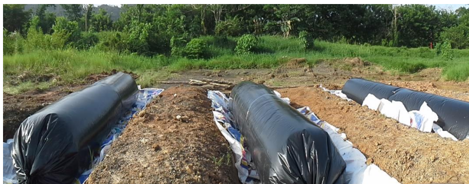
Figura No. 10. Instalación de 3 digestores (Trabajo de Campo, 2015)
