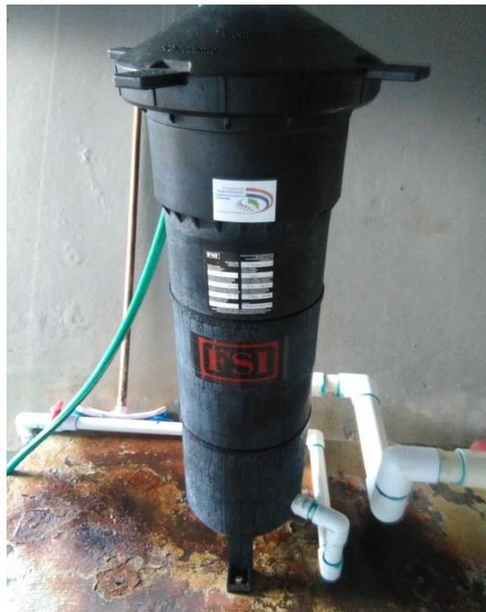
**Figura No 5.** Filtro de arenas 50 $\mu$ m marca FSI (Trabajo de Campo, 2015).
