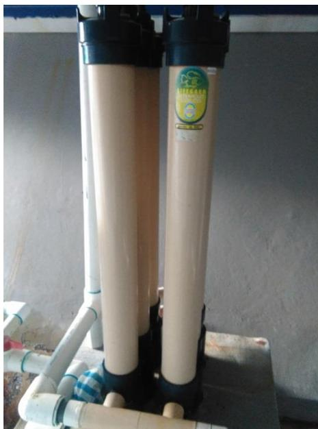
**Figura No 6.** Filtro de Luz UV marca LifeGard Rainbow (Trabajo de Campo, 2015).
