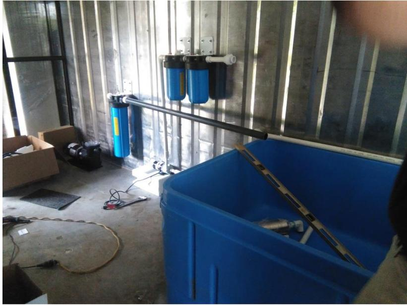
**Figura No. 27** Instalación de la Depuradora de ASOPEZ.
