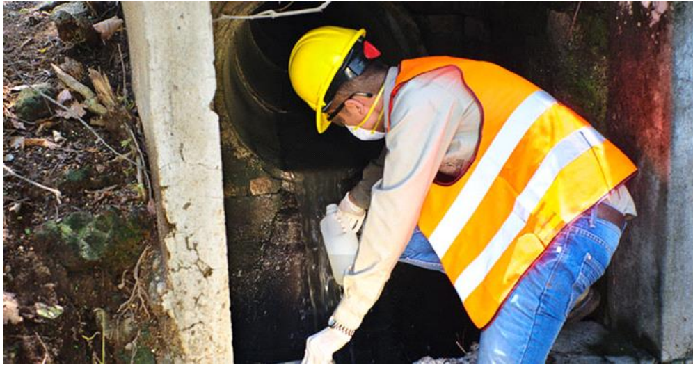
Fig. No. 4 Toma de Muestras en tuberías (Ecosistemas, 2015)
