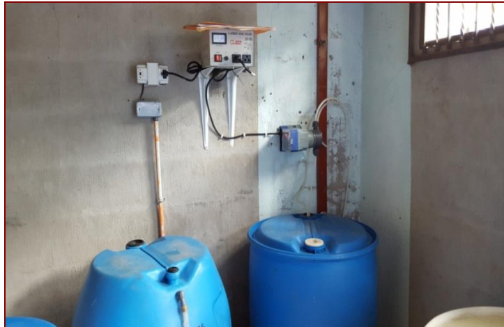
Figura No. 6. Forma de instalación Arriba del nivel del tanque (Trabajo de campo, 2015)
