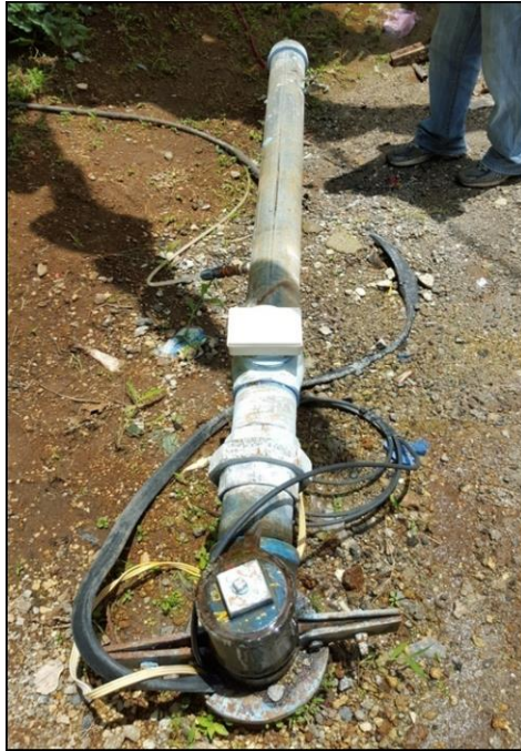
Figura No. 42. Punto de toma de muestras (Trabajo de campo, 2015)
