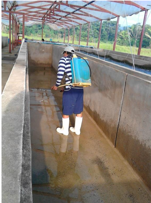
Figura No. 24 Desinfección de piletas
