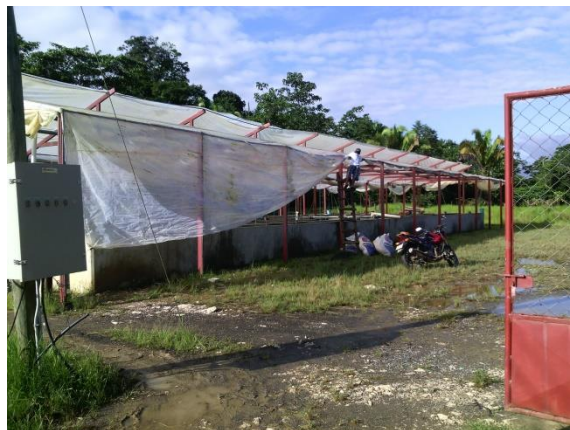
Figura No. 26 Instalación de invernadero
