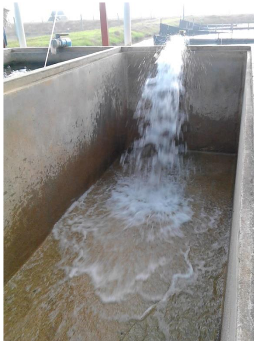
Figura No. 25 Llenado de pileta
