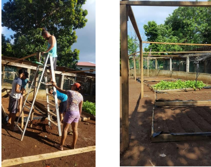
Figura 4: Construcción de vivero en la escuela pública Alton J. Cooper.
