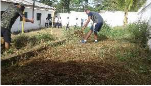
(Cruz, 2017) Limpieza del terreno
