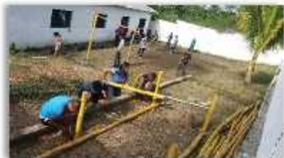
(Cruz, 2017) Colocación de Tierra Tratada
