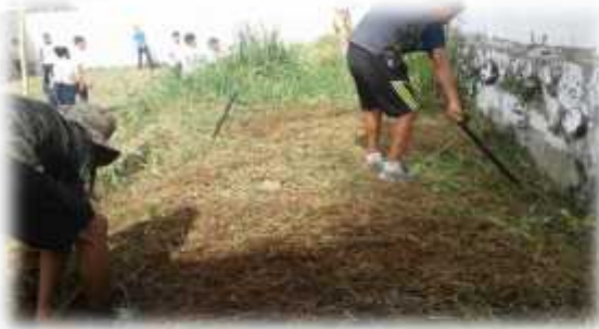
(Cruz, 2017) Limpieza del área del terreno
