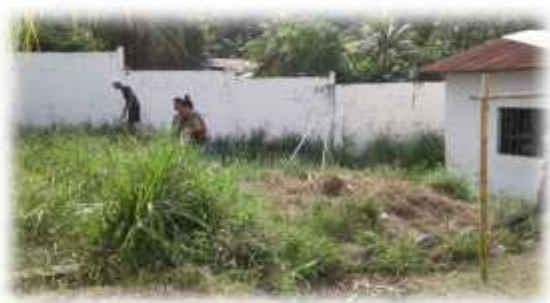
(Cruz, 2017) Limpieza del área del terreno
