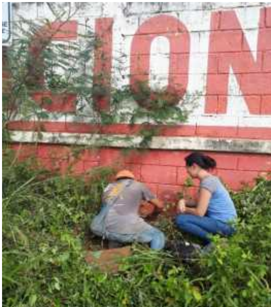
Instalación del medidor de agua. Elaborada por epesista
