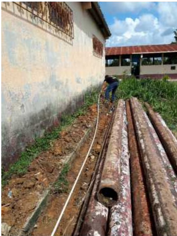
Reacomodación y unión de tubería que distribuye el agua a los baños de los jóvenes. Elaborada por epesista.
