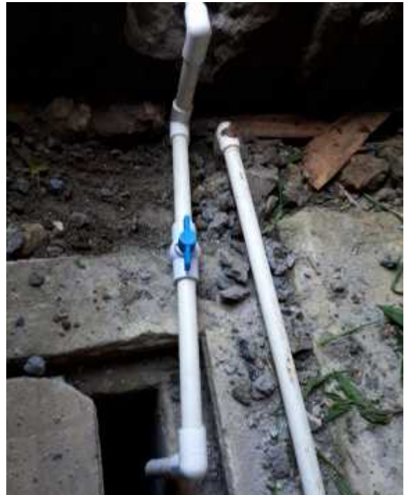
Única unidad de captación del centro educativo ya con la tubería instalada. Elaborada por epesista
