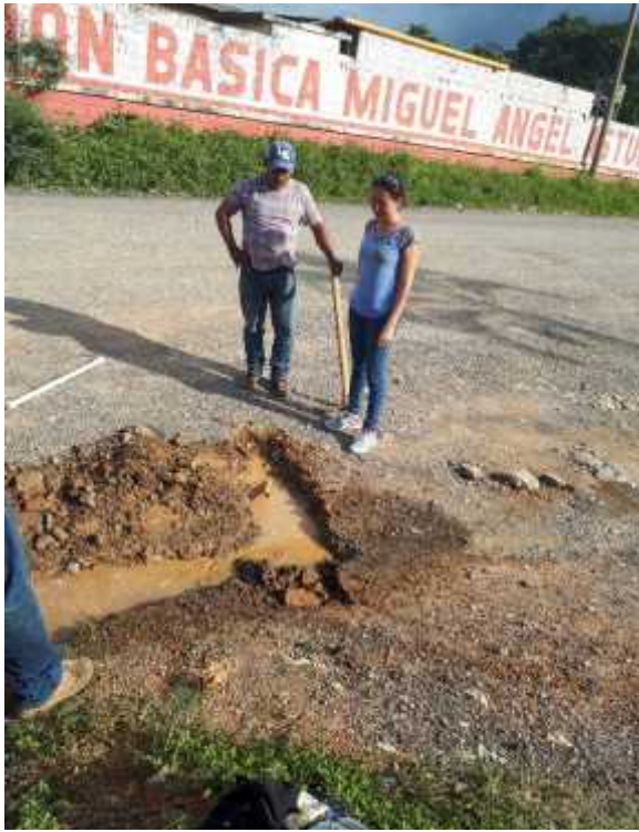
Reinstalación del servicio de agua. Elaborada por epesista
