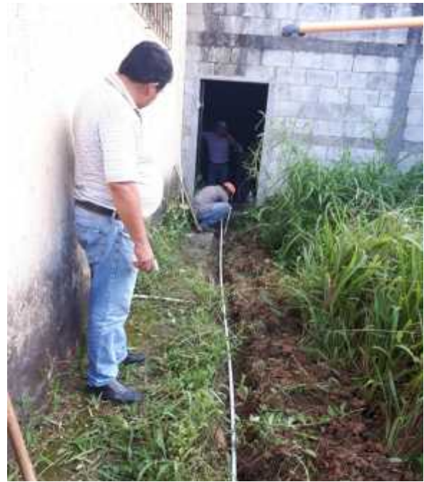
Supervisión del Director PEM Gerber Nova, de la nueva red de PVC que distribuye el servicio de agua a la institución educativa. Elaborada por epesista
