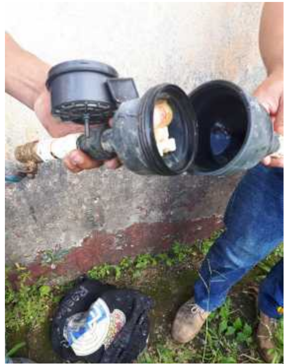
Revisión y reparación del medidor de agua del establecimiento educativo. Elaborada por epesista
