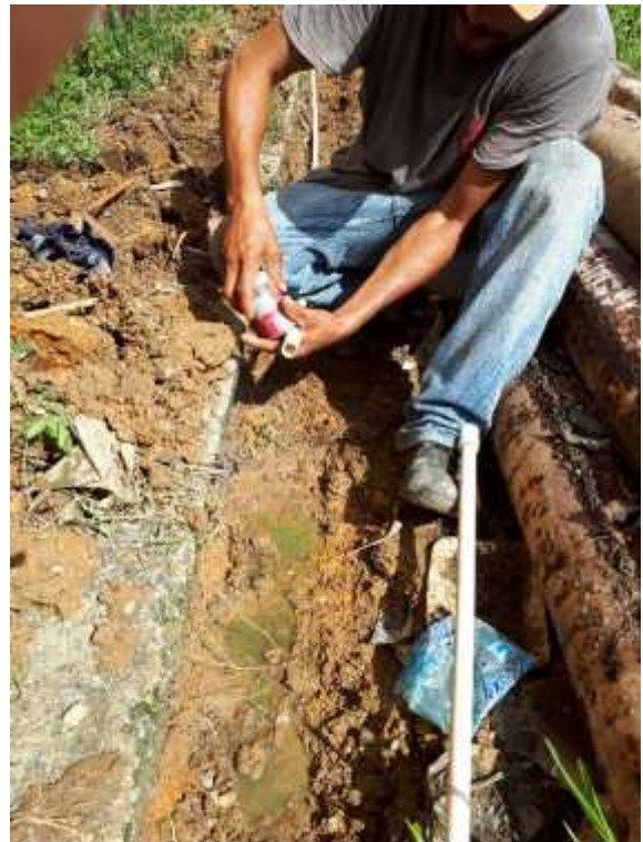
Reacomodación y unión de tubería que distribuye el agua a los baños de los jóvenes. Elaborada por epesista.
