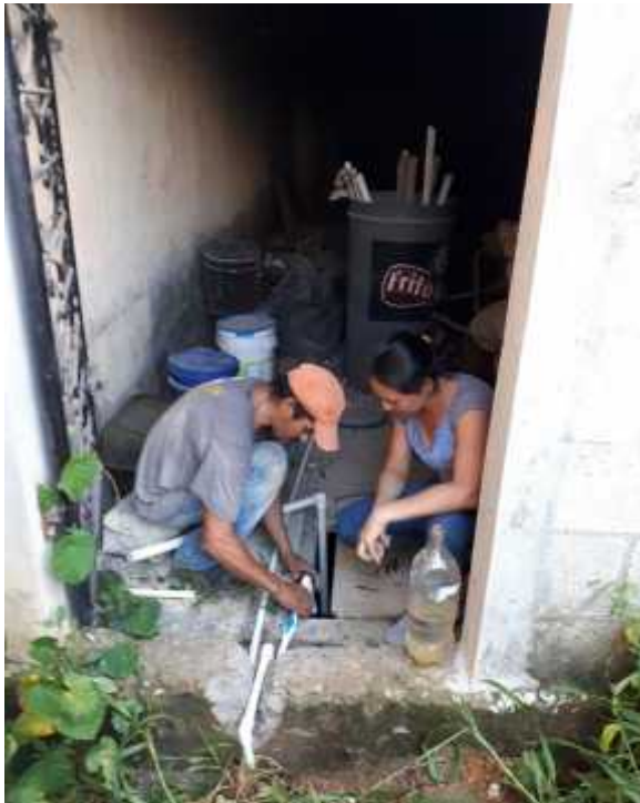
Instalación de la red de agua al tanque de captación del establecimiento. Elaborada por epesista
