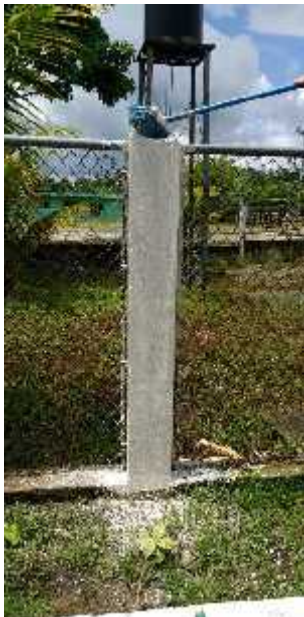
Encalando las bases de la malla perimetral. (Machorro, 2017).
