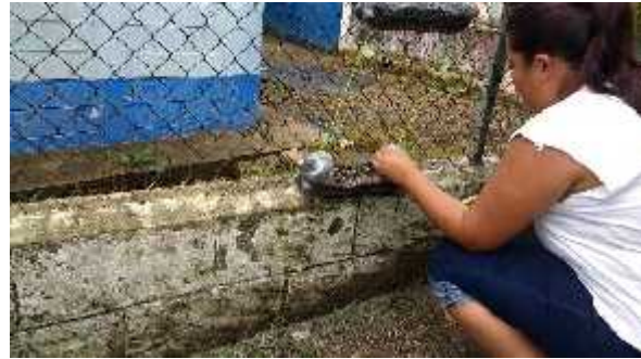
La epesista raspando las bases de la malla perimetral. (Machorro, 2017).
