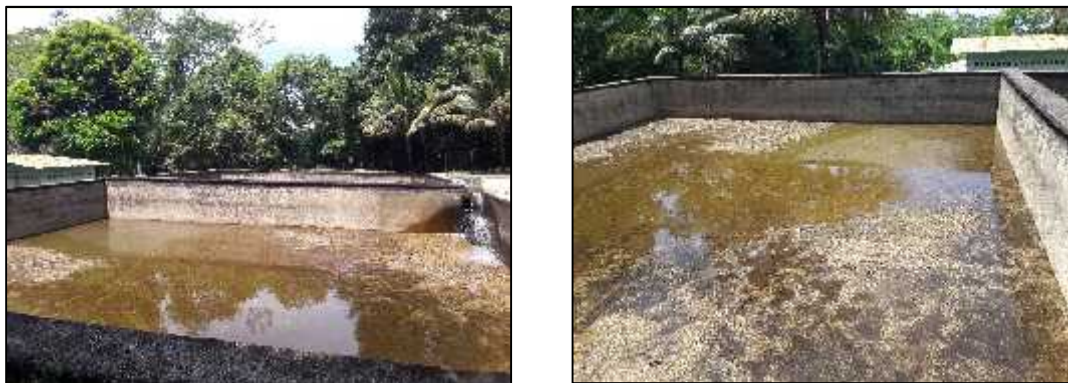
Figura 22. Tanques de captación de la presa. Elaboración propia.
