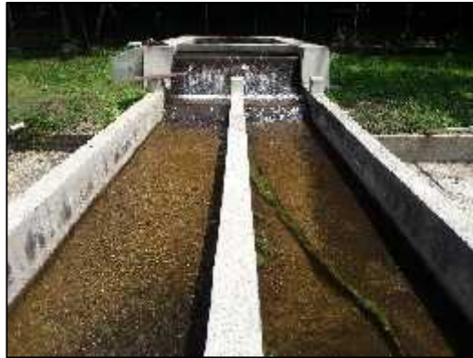
Figura 21. Estructura de la presa. Elaboración propia.
