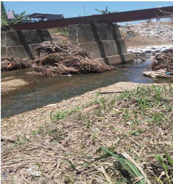
15.3. Cauce del río
