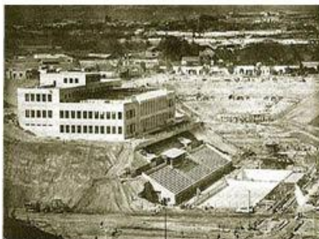
Fotografía No.6 Construcción en los barrancos de la Barranquilla zona 5
