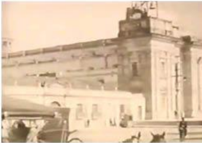
Fotografía No.3 Reconstrucción de la Catedral Metropolitana
