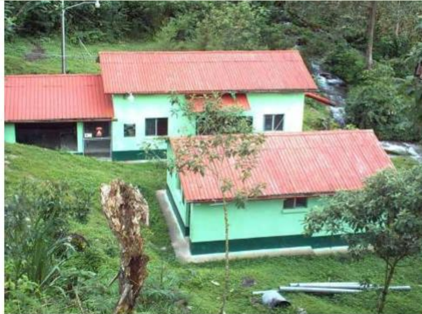
Conjunto de casa de máquinas y guardianía
