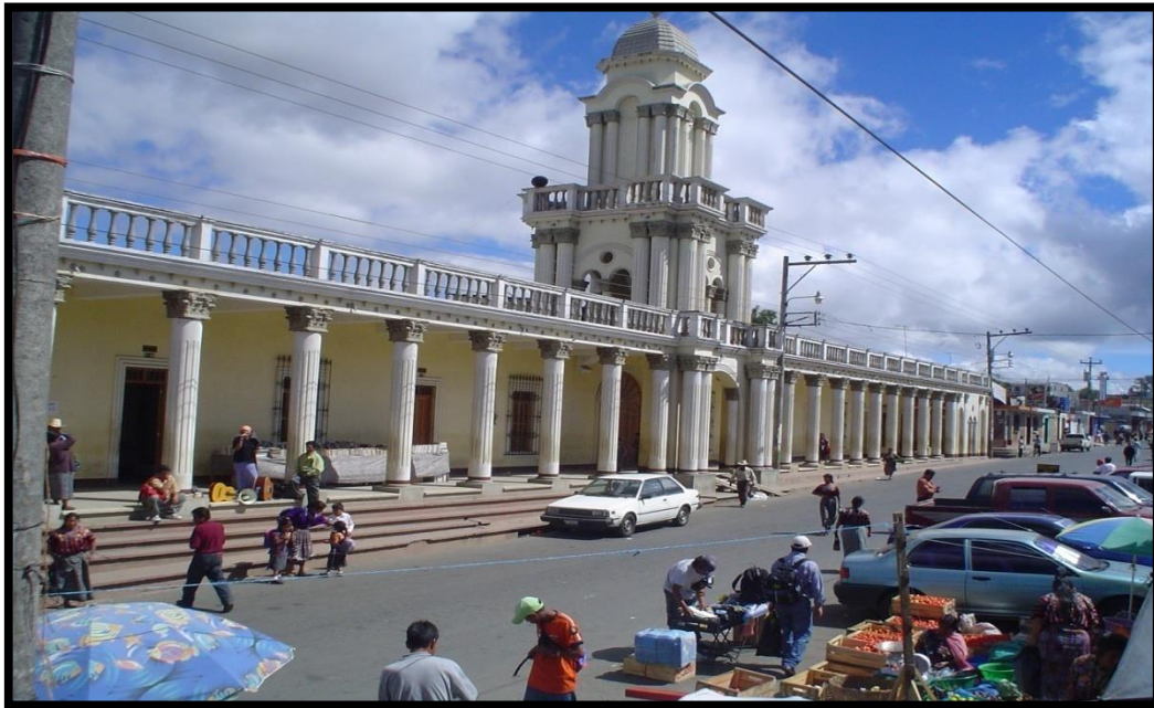
Palacio Municipal del Municipio de Patzún Chimaltenango
