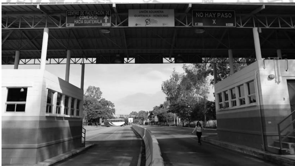
Figura 7 – Paso de vehículos en los PFI
