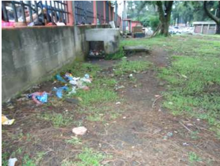
Fotografía No.8. Basureros externos sin control en la parte interior En áreas verdes que ponen en riesgo la Seguridad Medio Ambiental EFPEM/USAC Área que podría ser parte del Sendero ecológico de la USAC
