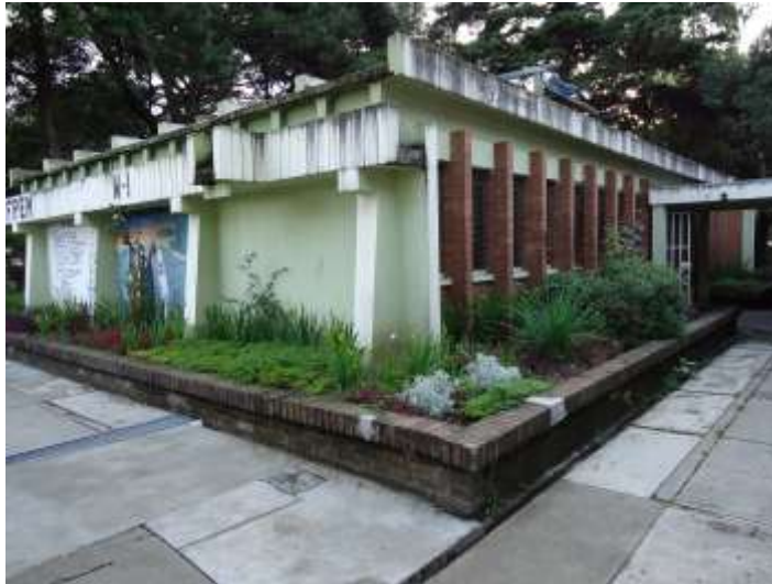
Fotografía No.2. Piso con zanjias puede causar accidentes
