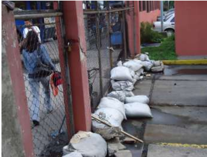
Fotografía No. 11. Barricadas que tratan de impedir el ingreso de Aguas pluviales a la EFPEM
