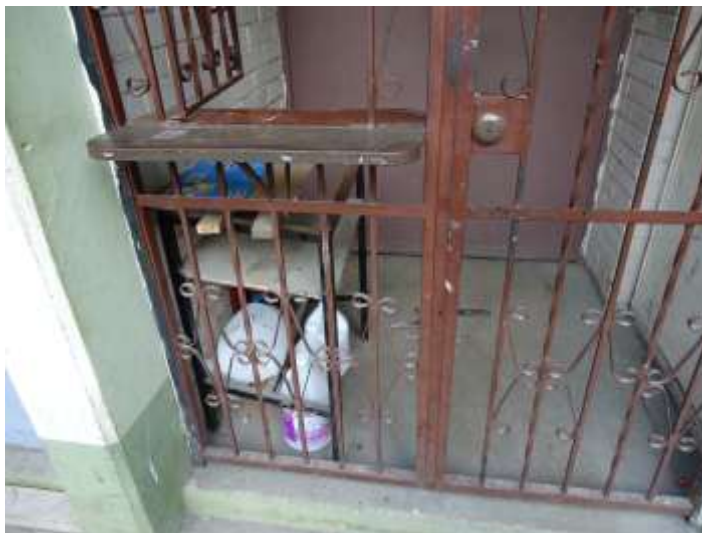
Fotografía No.3. Salidas obstruidas en casos de emergencia
