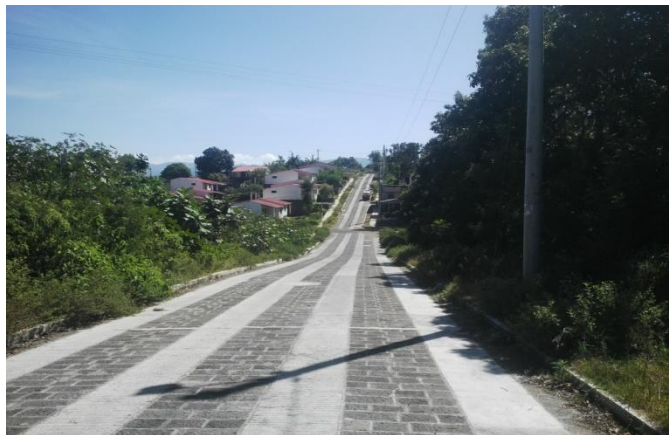
Fotografía No 12: Ingreso Principal de la aldea Chuk Muk II, donde está ubicada la ENBI.
