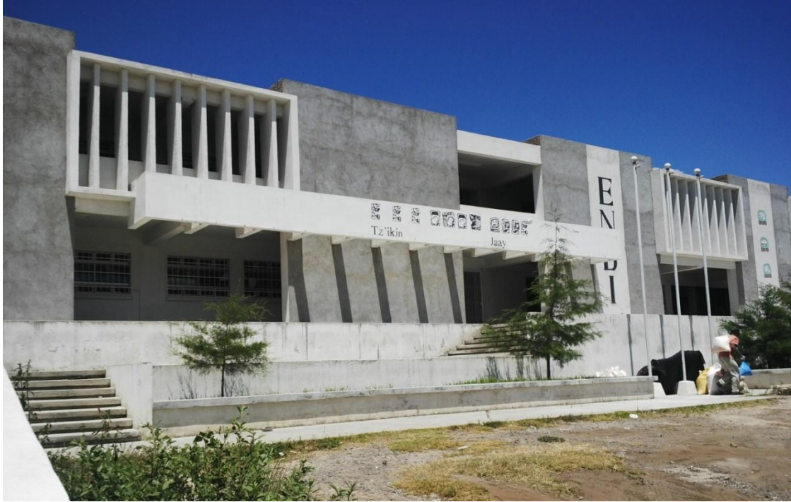
Fotografía No. 15: Parte frontal del edificio de la ENBI de Atitlán.
