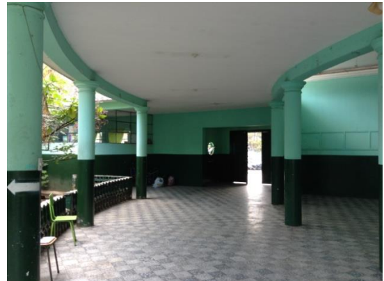
Foto 4 El salón de usos múltiples cuenta con el piso original y un escenario aceptable.
