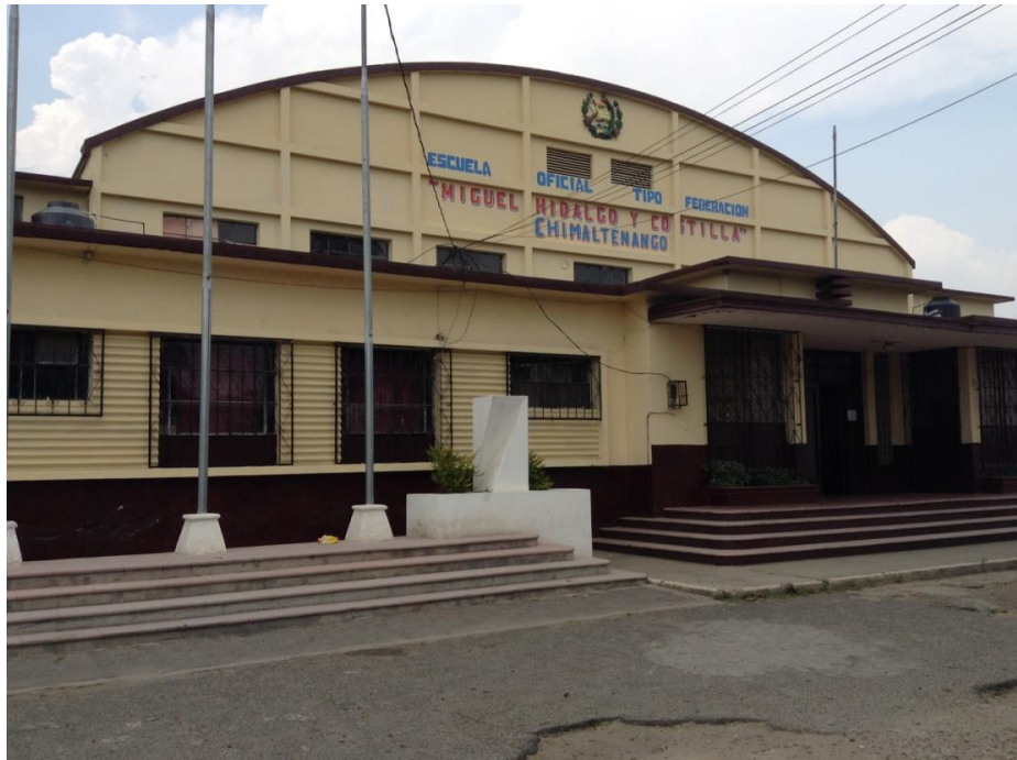
Foto 10 El frente de la escuela tipo federación Miguel Hidalgo y Costilla, de Chimaltenango.
