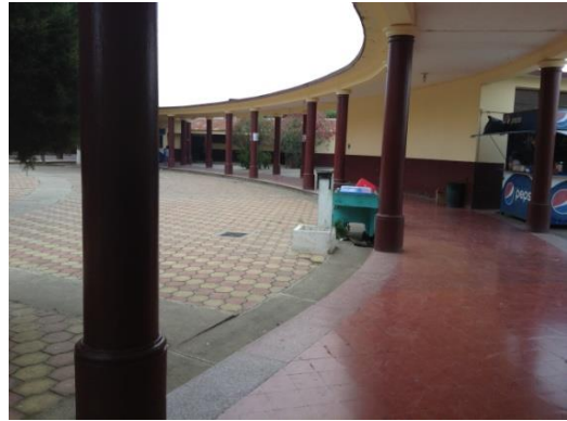
Foto 9 Los corredores de la escuela federal de Chimaltenango mantienen su esplendor y le dan brillantez a esta fotografía. Sus columnas son sólidas, y es una de las características de estas escuelas. La forma curvilínea es otra de las características.
