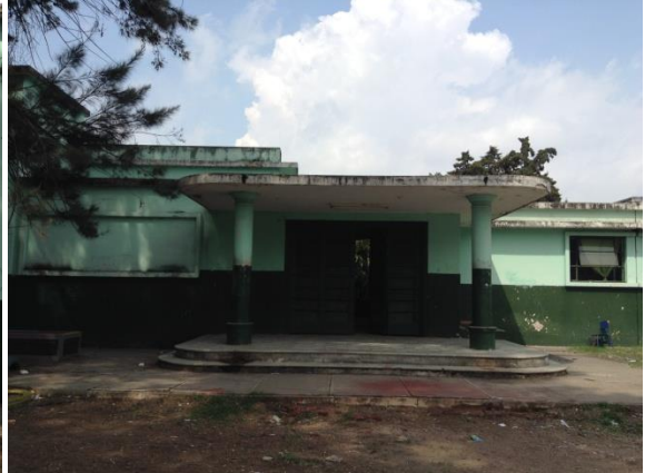
Foto 2 En la parte posterior de la Escuela Tipo Federación de Villa Nueva se observan columnas cilíndricas muy sólidas.
