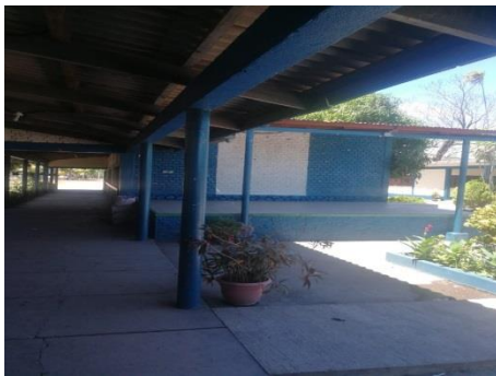
Fotografía 1 Aulas de la EORM
