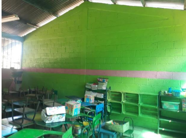
Fotografía No. 17 Aula pintada
