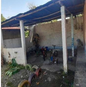
Ilustración No 12 Área que se ocupa como parqueo
