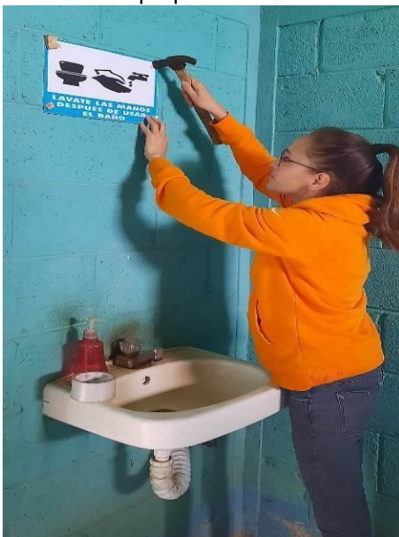
Fotografía No. 14 Colocación de pequeñas mantas vinílicas
