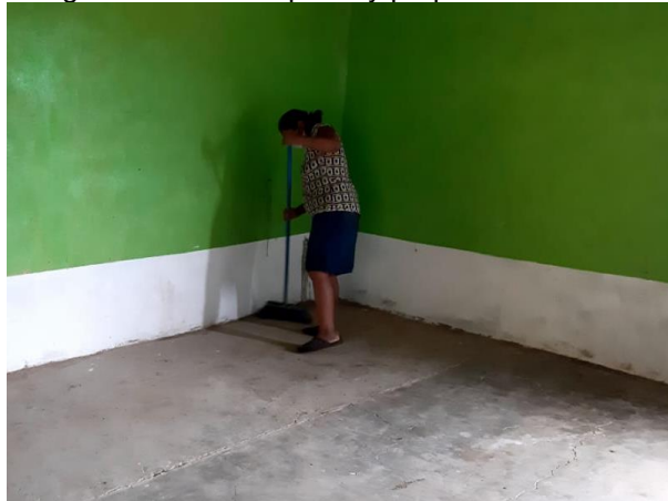
Fotografía No. 12 Limpieza y preparación del salón
