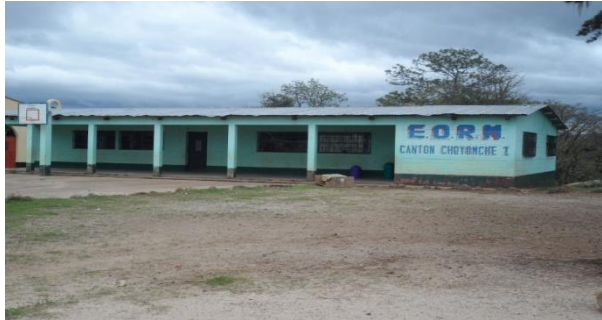
Edificio escolar de EORM Cantón Choyomché I
