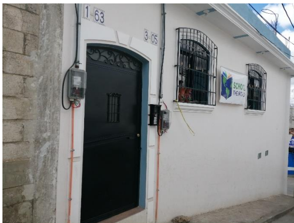
Foto No. 6 Fachada de ONG
