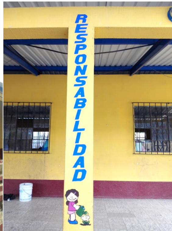
Fotografía No. 30. Letrado terminado
