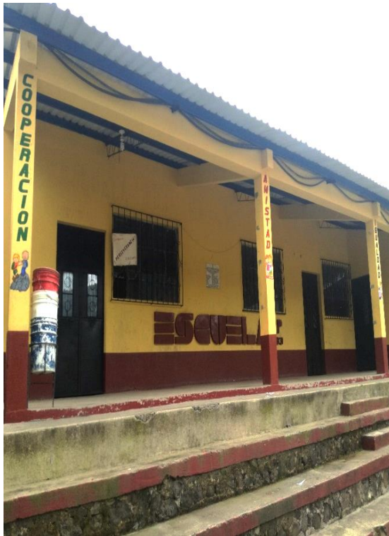
Fotografía No. 29. Letrado terminado
