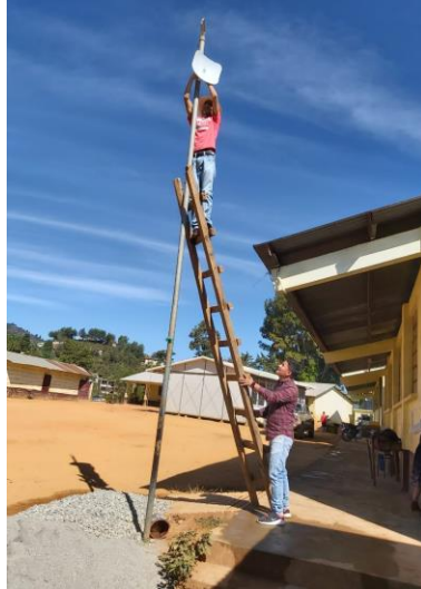
Fotografía 9. Instalación de antena
