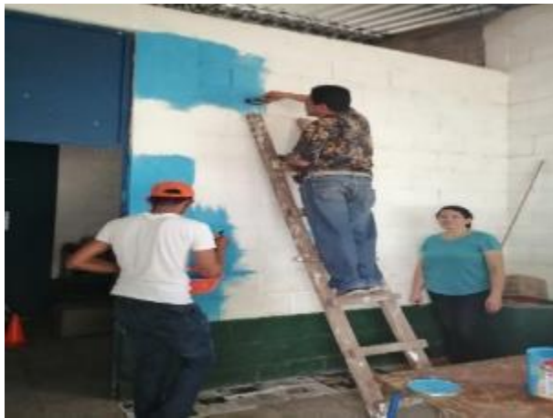
Fotografía 18 Pintando edificio escolar
