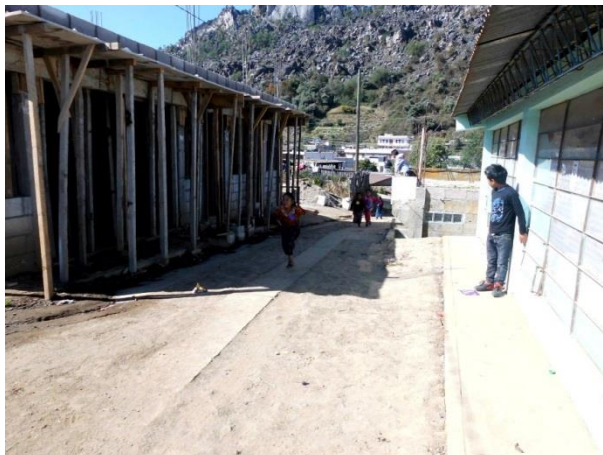
Imagen No. 1 Construcción EORM
