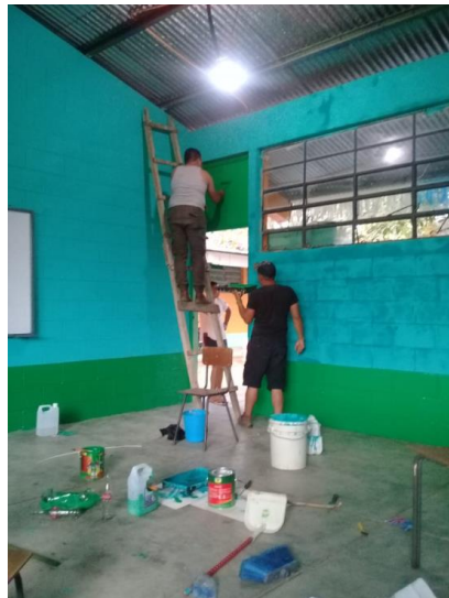
Imagen No. 11 Remosamiento del aula con pintura
