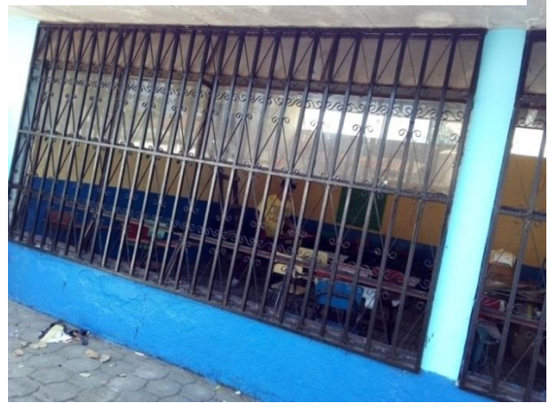
Ilustración 12 Cambio de pintura del exterior
