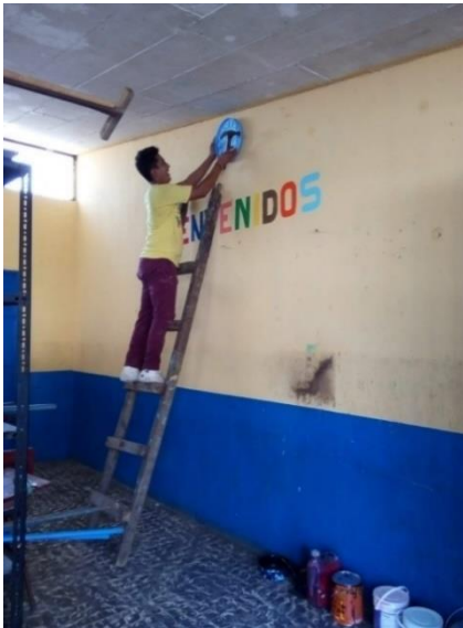
Ilustración 13 Cambio de pintura del interior
