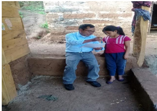
Fotografía No. 11 Ejecución del proyecto
