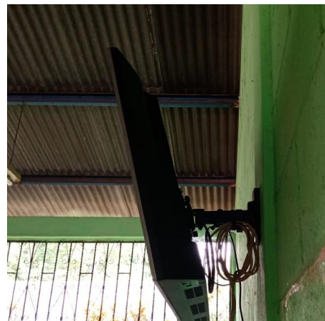
Fotografía 18, fuente propia, panorámica de TV fijado a la pared
