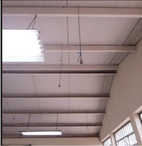
Fotografía No. 21. Techo del laboratorio.
