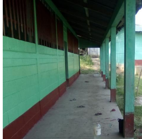
Fotografía 13 Verificación de espacios físicos.
