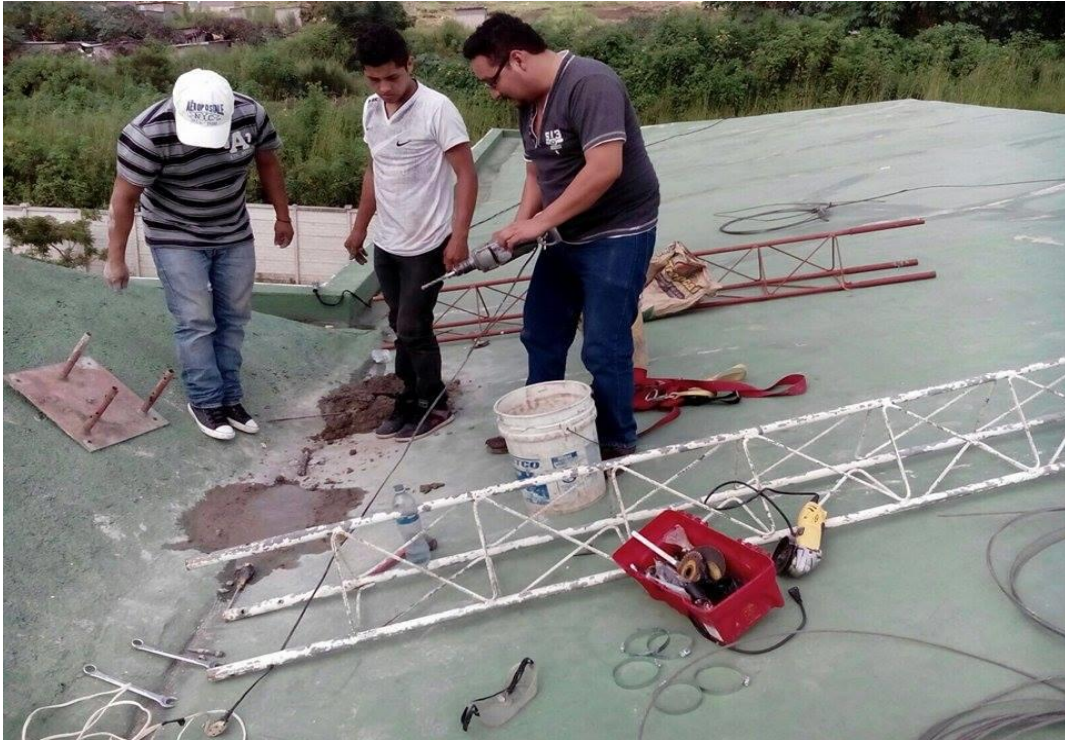
Fundición de la base de la torre metálica.
