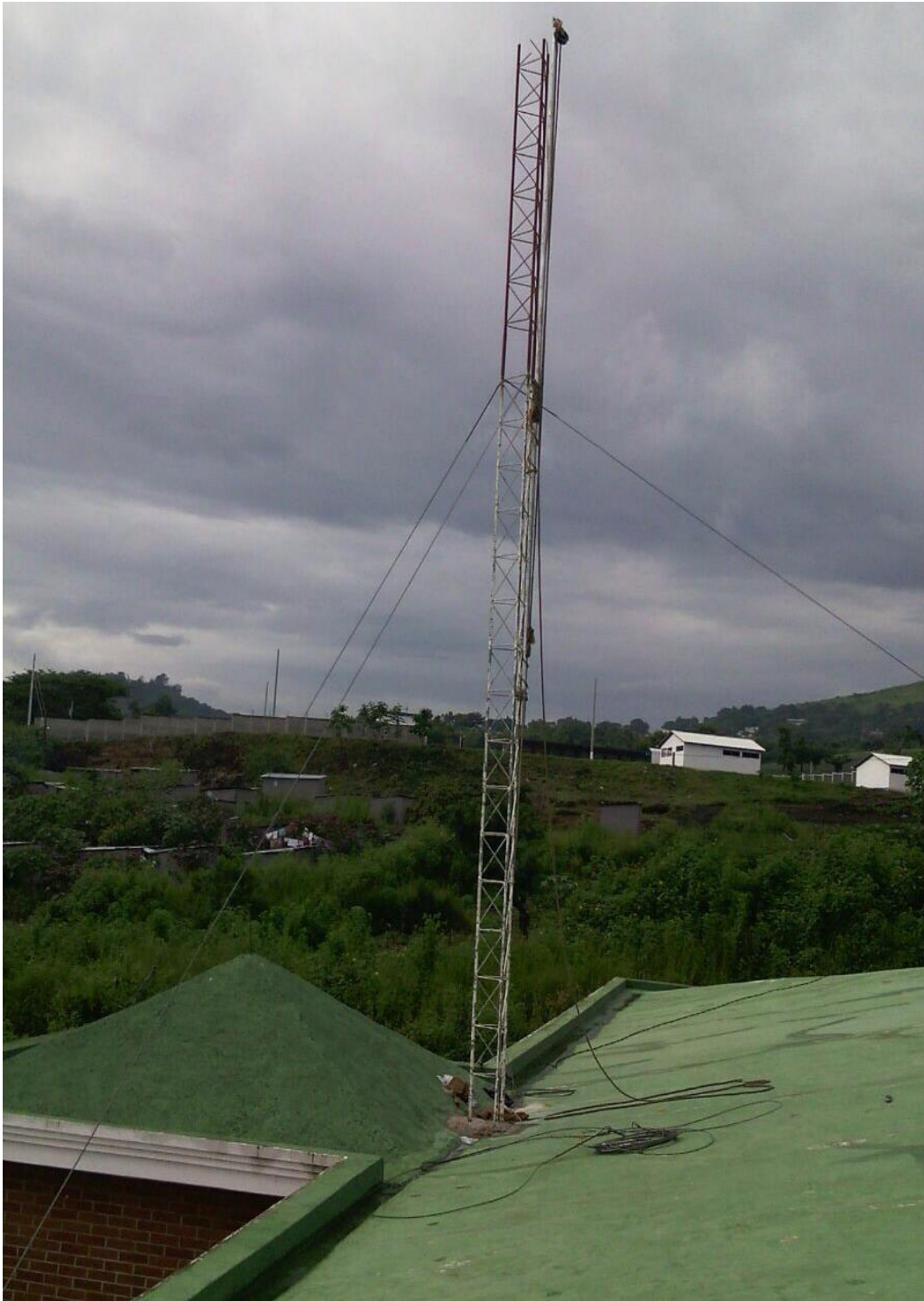
Instalación de torre metálica en el edificio universitario.
