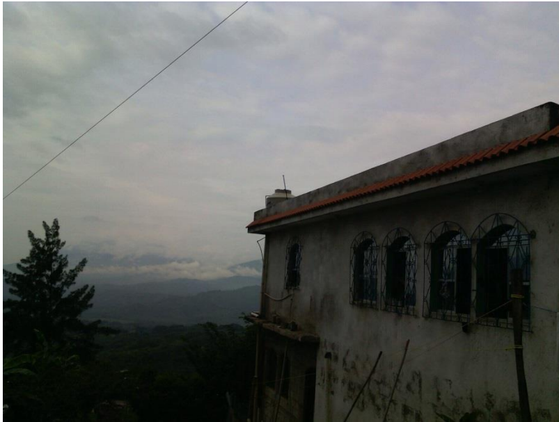
Vivienda donde se instaló la torre en el casco urbano de Cuilapa
