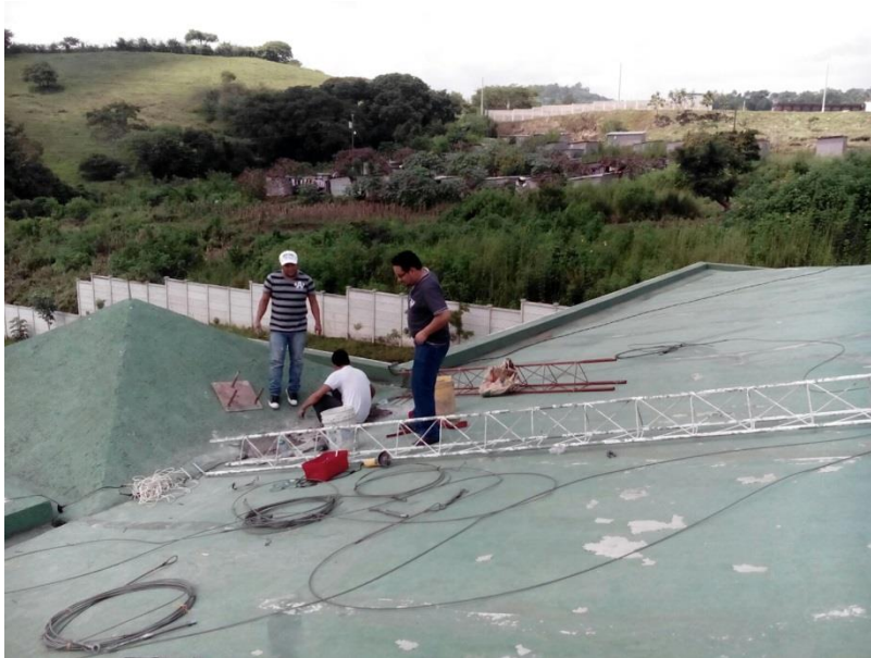
Instalación de la torre en CUNSARO
