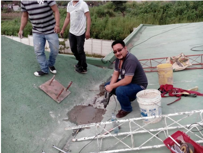
Epesista apoyando la instalación
