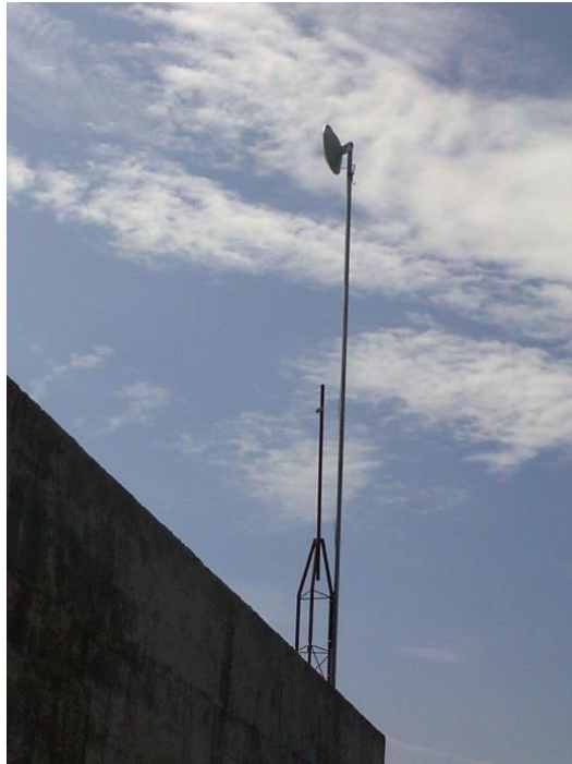
Torre instalada en Cuilapa
