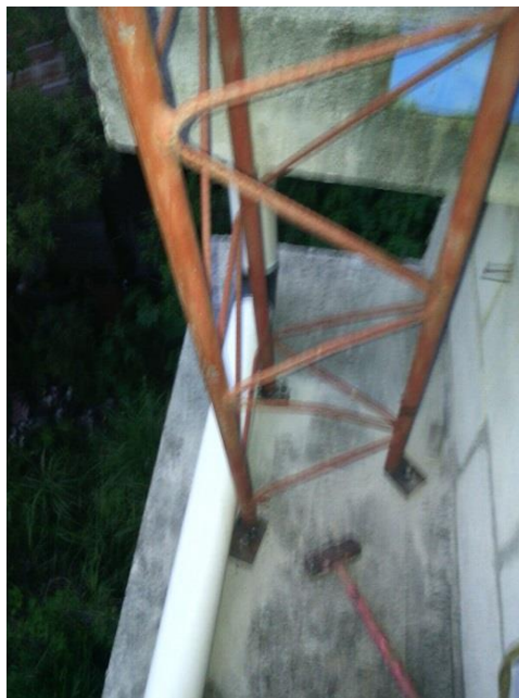
Base de la torre instalada en el casco urbano de Cuilapa
